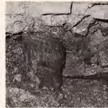
16 Paalfundering met kespen onder de rechterbouwmuur van Keizersgracht 62
